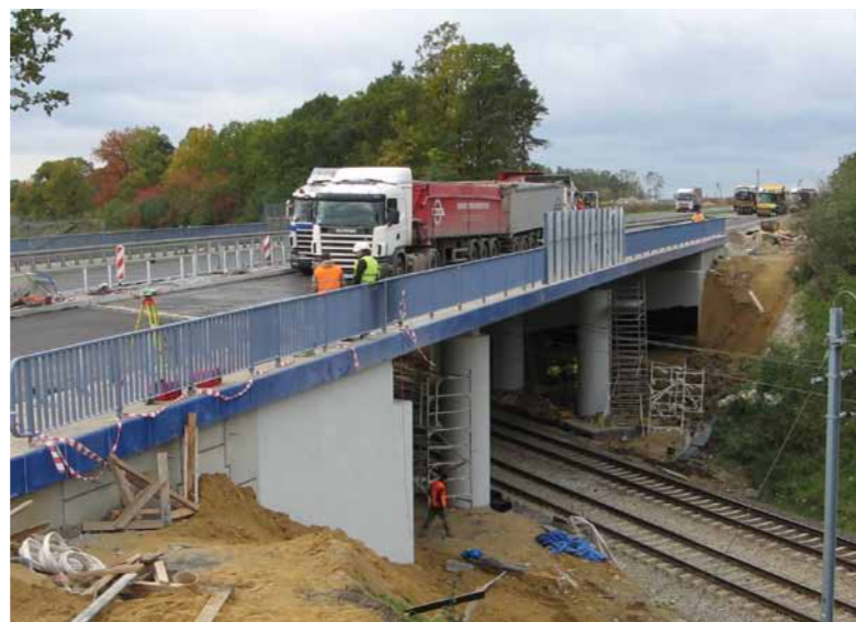
> BADANY WIADUKT POD PRÓBNYM OBCIĄŻENIEM - PRZESŁO ŚRODKOWE
