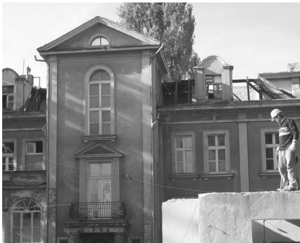
Remont biblioteki w Nowej Soli
