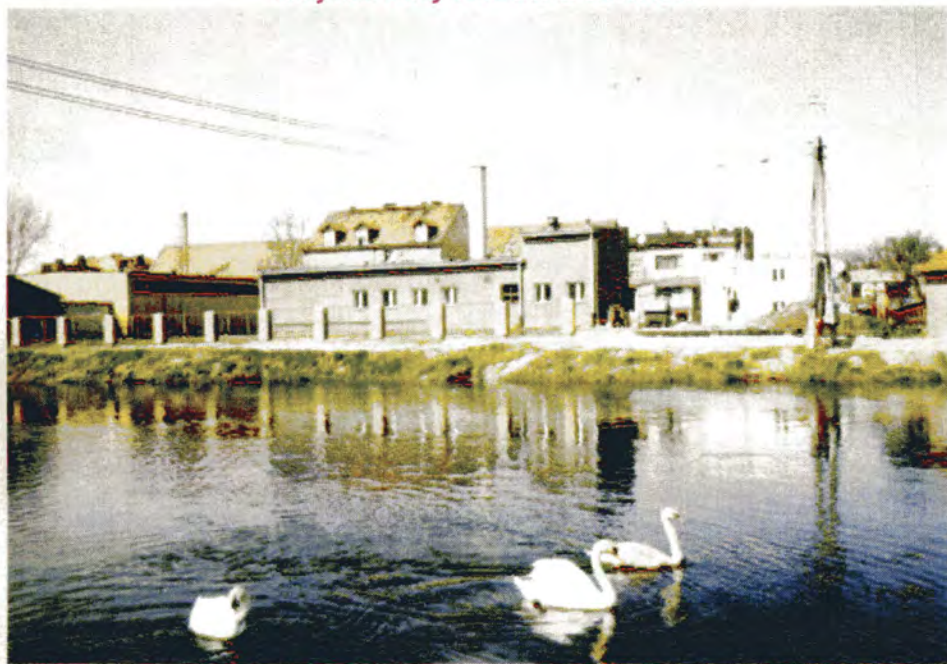
Główna przepompownia ścieków
