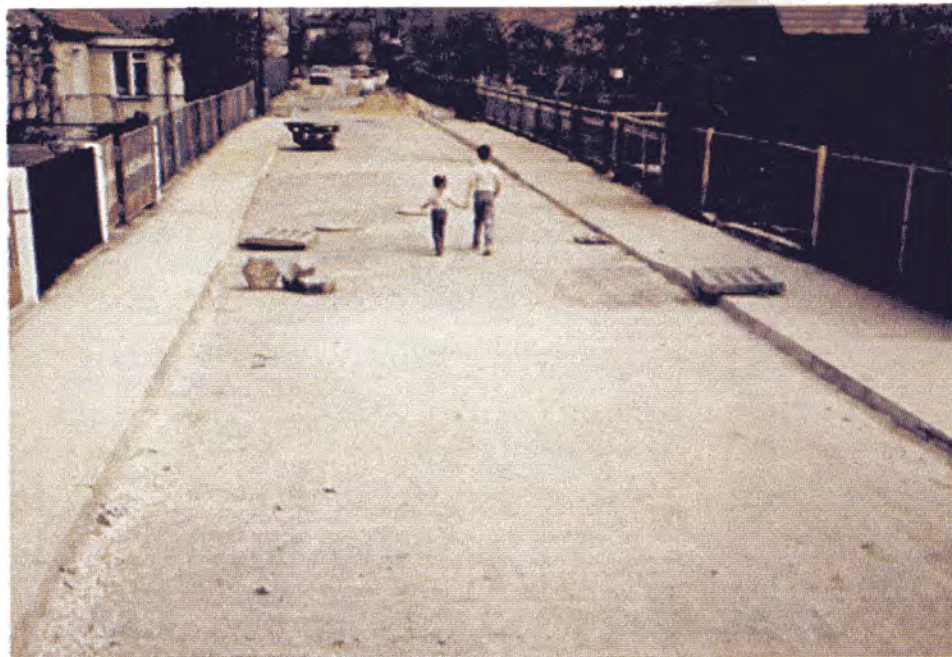
Chodniki i pierwsza warstwa nawierzchni ulicy Sienkiewicza
