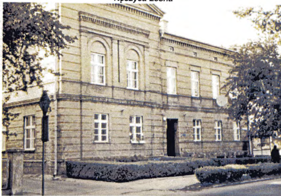
Budynek komunalny wyremontowany po pożarze
