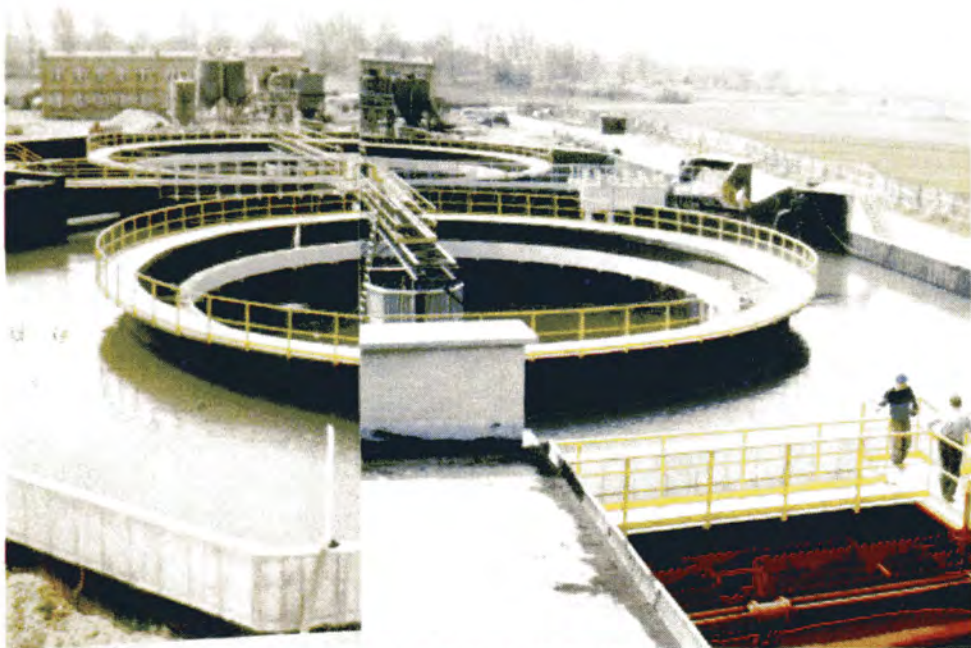
Miejska oczyszczalnia ścieków
