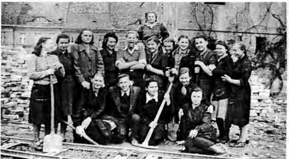
25 kwietnia 1950r. młodzież P.L.A.H. wzięła udział w pracach przy odgruzowywaniu obiektów przyrynkowych.
