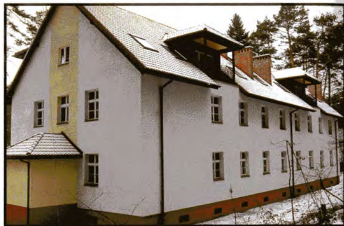
Blok mieszkalny w Kęszycy Leśnej - po remoncie jak nowy.
