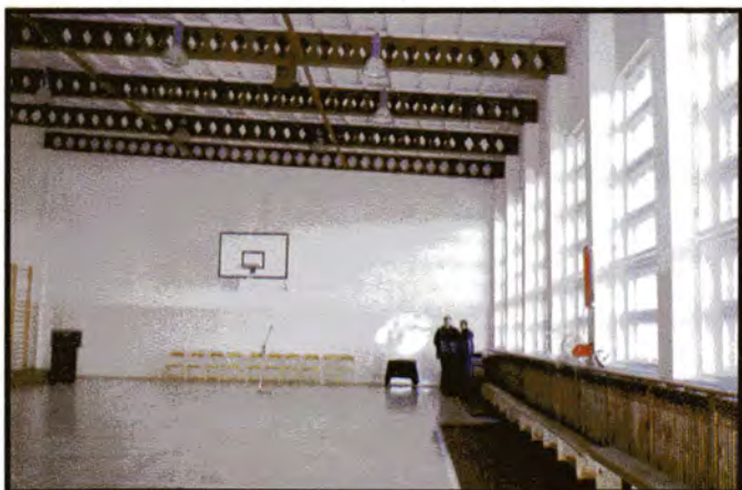
Stalowa konstrukcja w sali gimnastycznej w Radoszynie
