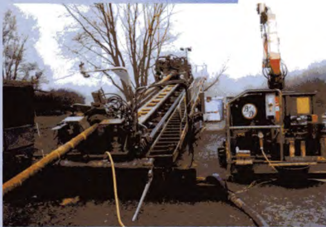
Ogromna wiertarka, której wiertło sięga drugiego brzegu Odry
