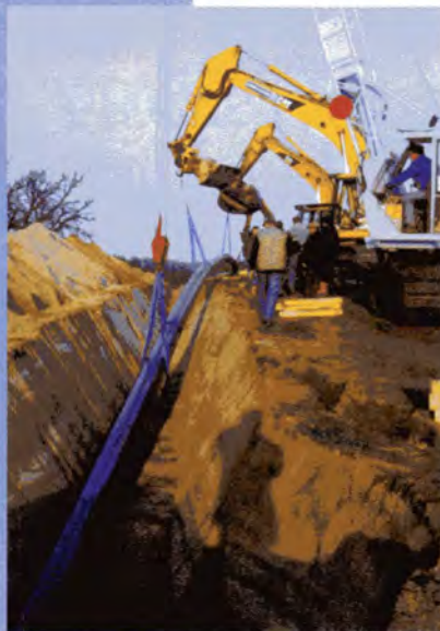
Budowa gazociągu wysokiego ciśnienia po polskiej stronie - w kierunku Kostrzyna i Słubic
