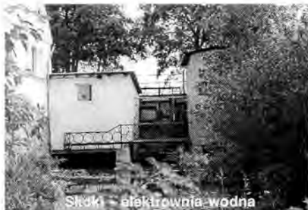
Skoki – elektrownia wodna
