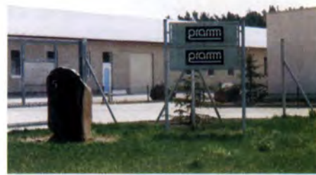
W Karolewie trwa budowa zakładu produkcji elementów galwanicznych „Gramm”. Pierwsza grupa pracowników jest już na szkoleniu w Niemczech. Docelowo przy produkcji metalowych i żeliwnych części różnych urządzeń będzie pracowało ponad 40 osób.
