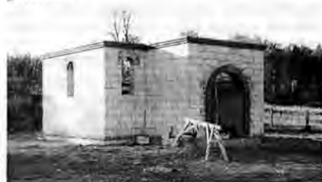
Budowa Domu Przepogrzebowego w Bukowcu
