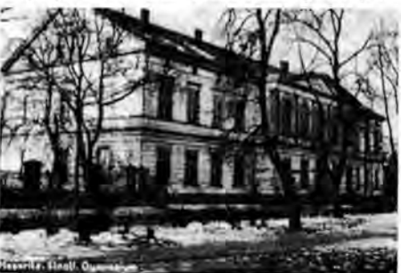
Budynek gimnazjum spalony w 1945r.
