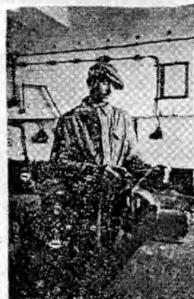
zobowiązali się skrócić czas pracy remontu cyklonu o 70 godzin. Zobowiązanie wykonali przed terminem.
