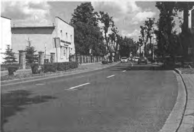
Kanalizacja na ul. Poznańskiej
