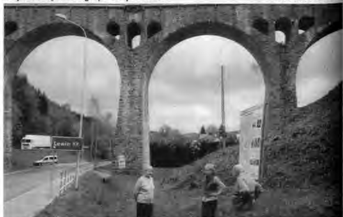
Most kolejowy nad drogą krajową nr 8. Został zaprojektowany przez włoskich inżynierów i wybudowany przez robotników przymusowych w latach 1903 – 1905 jako kamienny, jednotorowy, wieloprzęstowy wiadukt kolejowy o wysokości 27 m i rozpiętości 102 m. Lewin Kłodzki, 5 maja 2013 r.
