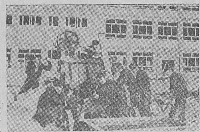
Na budowie nowej szkoły przyzakładowej GPB „Zachód”.
