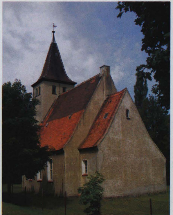
Kościół pw. św. Antoniego w Kursku zbudowany w 1938 r. (fot. J. Krajniak)
