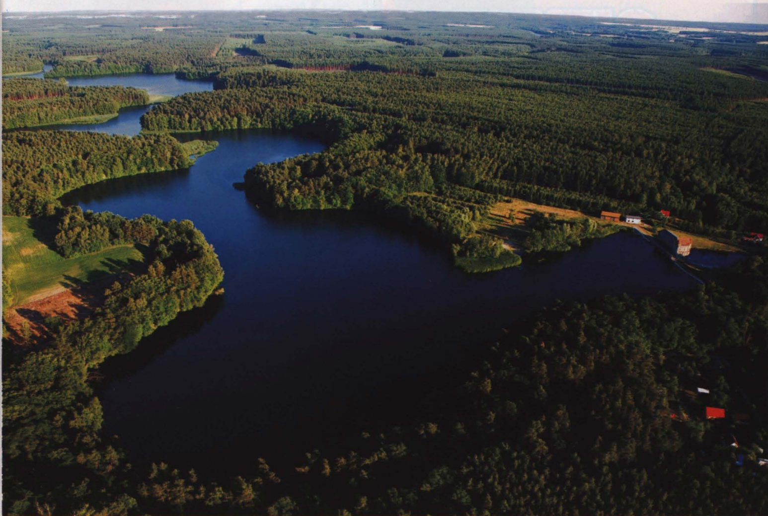
Zalew Bledzewski, zapora i elektrownia (fot. archiwum UG w Bledzewie)
