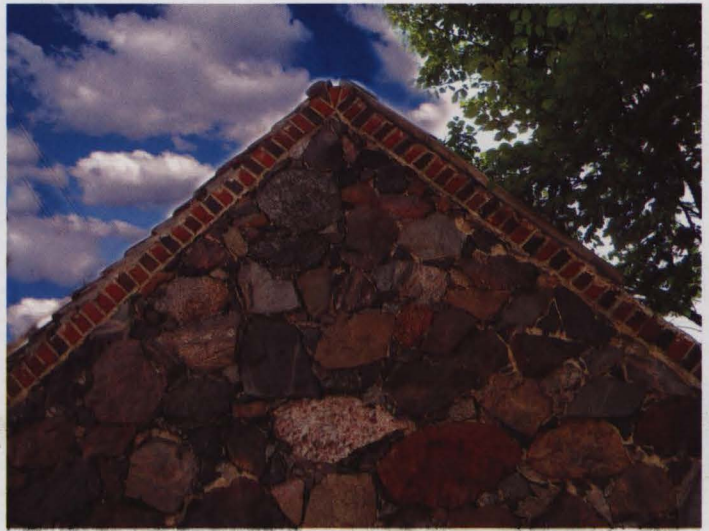
Fragment ściany szczytowej budynku gospodarczego z ciosanych narzutniaków w Gorzycy (fot. J. Krajniak)
