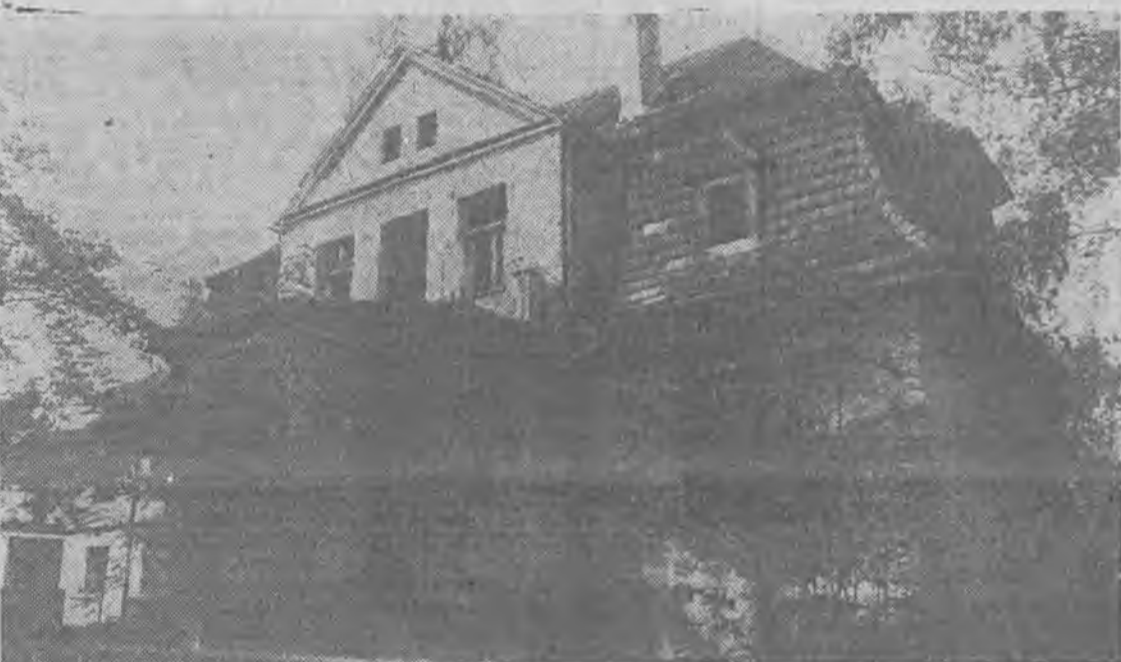
Zniszczeń dokonano „na prawach wojennych”. Tak wyglądają budynki pozostawione w Żaganiu przez opuszczające miasto wojska radzieckie. Fot. Kru-Krz
