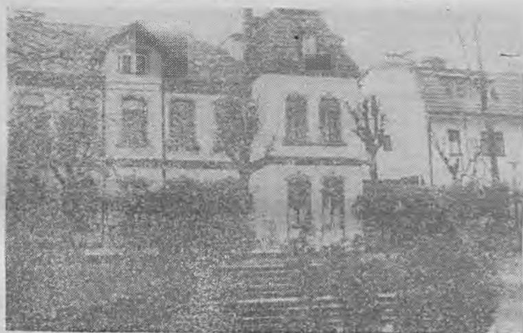
Zdjęcie zamieszczone w nrze 2 na str. 3 — wbrew wątpliwościom — przedstawia budynek WOKI, tyle, że nie od strony frontowej. Zdjęcia powyżej to także WOKI.
