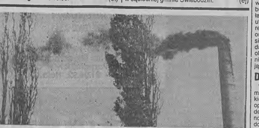
Nowa Sól — komin Zakładów Jajczarskich. Ani kierownictwo tej fabryki, ani pałac nie przejmują się widocznymi nawoływaniem ekologów o ochronę środowiska naturalnego. Fot. Marek Woźniak
