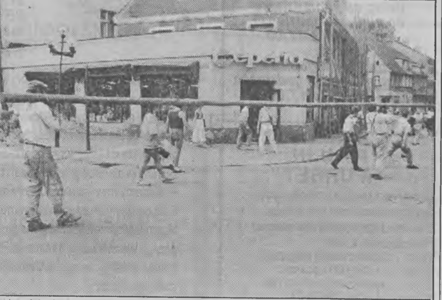
Zanim założy się ruszowanie trzeba przetransportować jego elementy na własnych barkach. Fot. Krzysztof Mężyński
