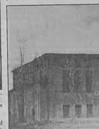
Budynek kotłowni, w której ciepło dostarczano do wszystkich obiektów zakładowych. Piece opalano miałem węglowym, sprowadzonym z kopalni Górnośląska. Jednocześnie w koksowych generatorach produkowano gaz, stosowany w procesach technologicznych przy produkcji kwasu siarkowego i azotowego.
