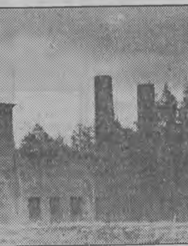
Zakład czerpal wodę również z Bobru. Na brzegu rzeki zbudowano dwa olbrzymie zbiorniki, skąd woda była pompowana dalej trzema kolektorami o średnicy 80 cm. Zachowały się budynki mieszczące kiedyś stacje pomp i filtry, oraz liczne obiekty hydrotechniczne — śluzy, podziemne kanały, studnie i włązy kanalizacyjne.
