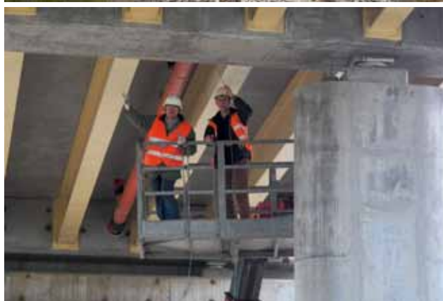
MONTAŻ APARATURY POMIAROWEJ POD BADAANIAMI WIADUKTEM (FOT. Z WYDZIAŁU)
