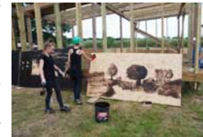
FOT. J. JUCHIMIUK, M. GOLAŃSKI, III ETAP BUDOWY EKSPERYMENTALNEGO HABITATU - BAĆ-ARKA
