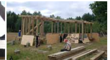
FOT. J. JUCHIMIUK, M. GOLAŃSKI, III ETAP BUDOWY EKSPERYMENTALNEGO HABITATU - BAĆ-ARKA
