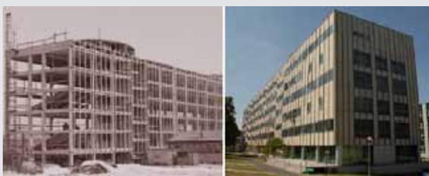
Budynek dydaktyczny A-2 w trakcie budowy (1985) i w czasie jego eksploatacji (lata 90. XX w.)
