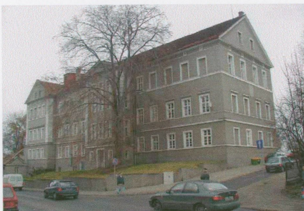
Fot. 1. Budynek Instytutu Fizyki WSP TK
