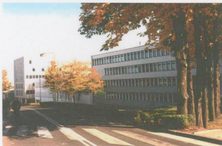
Fot. 2. Budynek Główny Politechniki Zielonogórskiej
