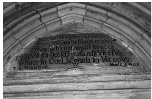
Portal w kruchcie zachodniej kościoła
