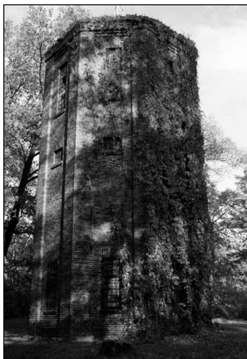
Wieża ciśnień w Jasieniu
