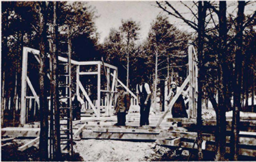
Der Architekt beim Richten des Holzfachwerks
