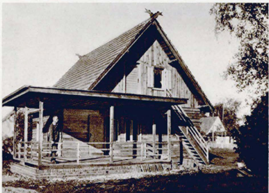
Ansicht der Ostseite, im Rohbau fertig
