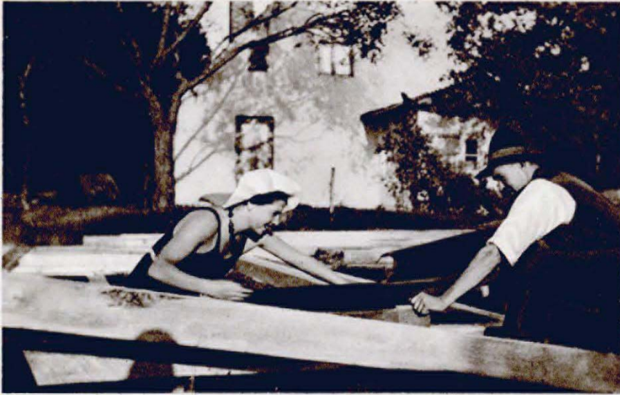
Der Architekt beim Zurichten des Gebälks
