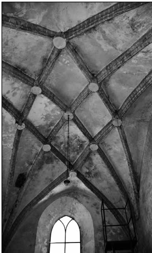
Sklepienie w kaplicy z XVI wieku
