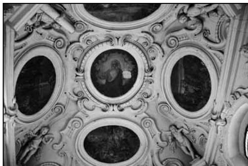
Sklepienie kaplicy Promnitzów
