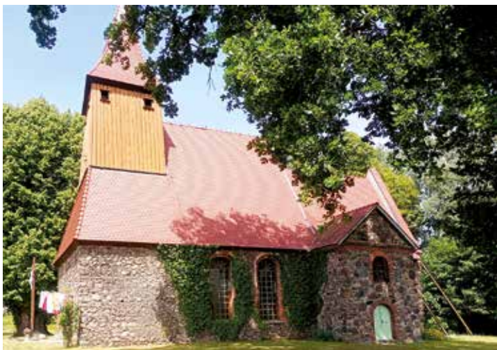
Fot. 61. Kościół w Kosierzu – stan w 2025 roku
