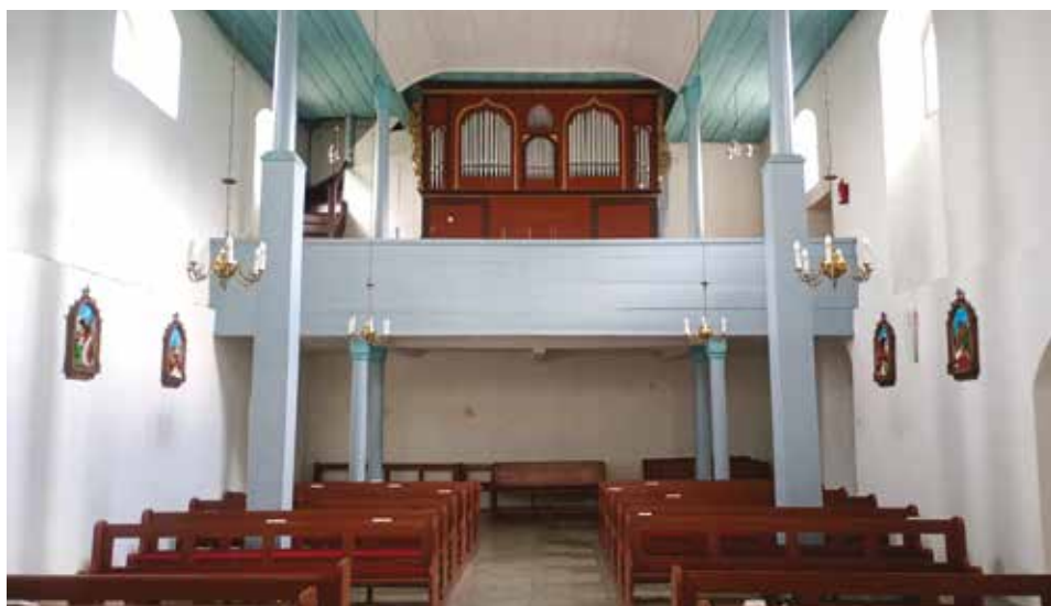
Fot. 20. Wnętrze kościoła w Janiszowicach – stan w 2025 roku
