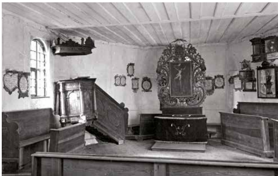
Fot. 48. Wnętrze kościoła cmentarnego w Bytnicy – stan około 1920 roku
