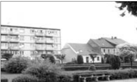
Fot. 2. Fragment zabytkowej zabudowy w Babimoście, zdewastowany wprowadzeniem do zabytkowego miasta budynku wielorodzinnego (fot. P. Dziezic)
