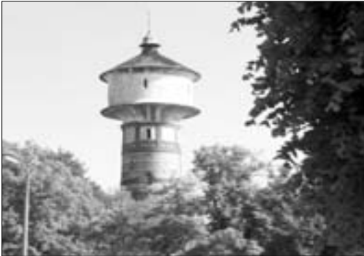
Fot. 8. Wieża ciśnieniowa w Sulechowie – zabytek oczekujący na remont (fot. P. Dziedzic)
