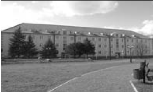
(zdj. 8, Siedziba Urzędu Gminy, odrestaurowany budynek koszarowy znajdujący się na byłym placu apelowym 4 Dywizji Zmechanizowanej, Źródło: fotografia autora)
