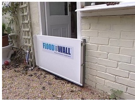
Rys. 4. Ściany przeciwpowodziowe [Floodwall 2010]
