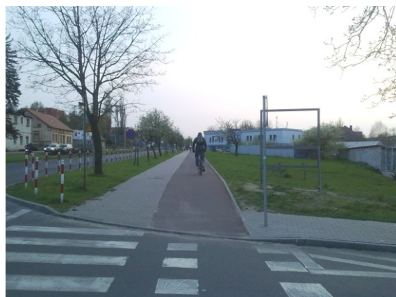
Fot. 4. Ścieżka rowerowa W1 wzdłuż ul. Łużyckiej z czerwonego asfaltu prowadząca w kierunku Wilkanowa Phot. 4. W1 bicycle path along the Łużycka street made of red asphalt, leading toward the Wilkanów village
