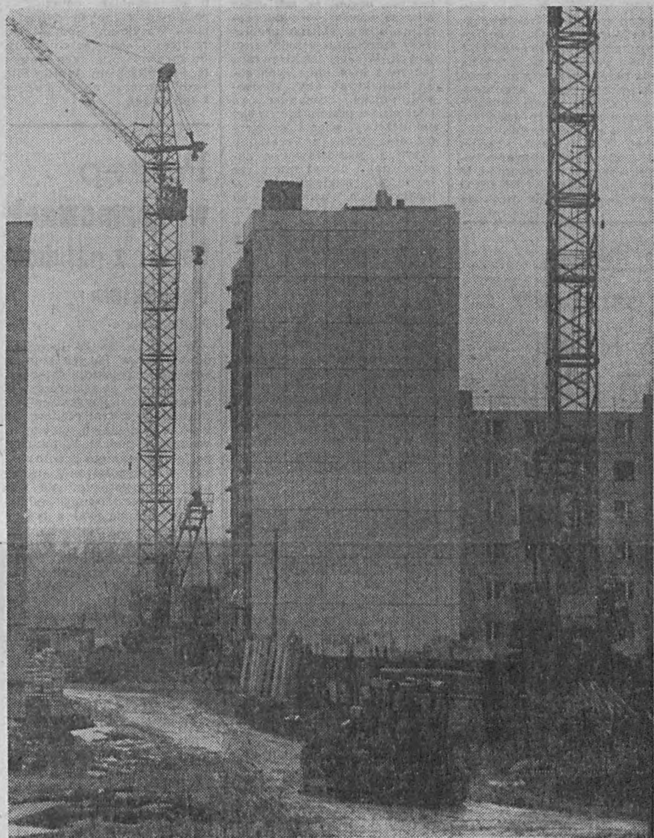
Budowa dziesiętnicy Kiszelskiej w Zielonej Górze.
