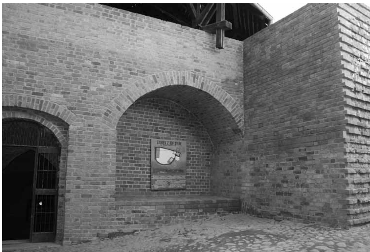
Fragmenty zamku po wykonaniu prac remontowych, fot. autor
