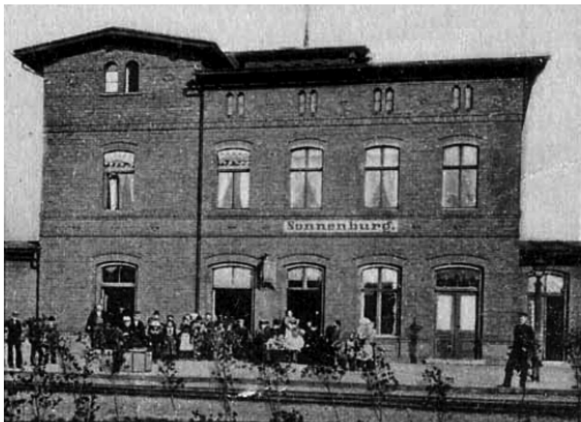
Dworzec kolejowy w Słońsku, zbiory M. Krzemińskiego
