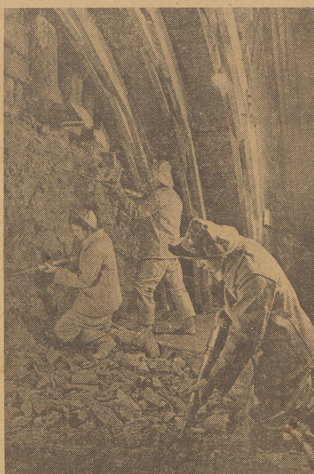
Leningrad będzie miał również kolej podziemną. Wzorując się na najlepszym metrze świata w Moskwie — robotnicy leningradzcy przystąpili do budowy potężnych wykopów, którymi już w niedalekiej przyszłości pobiegą szybkie pociągi kolejki podziemnej.
