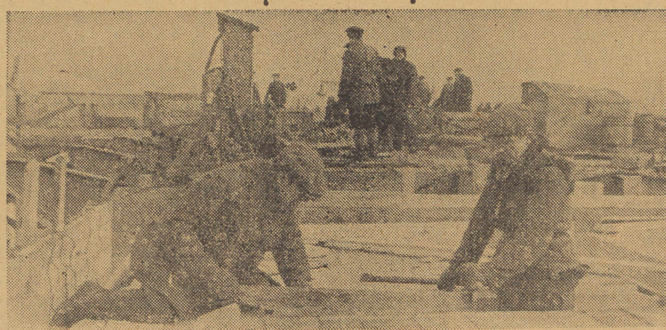
Ostatnie już prace przy budowie mostu śląsko-dąbrowskiego w Warszawie który stanowi jedno z głównych ogniwi arterii W—Z, szybko posuwają się naprzód. Na zdjęciu — układanie nawierzchni.
