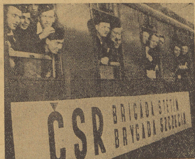
W odbudowie portu szczecińskiego bierze również udział młodzi Czechosłowacji. Na zdjęciu praska brygada pracy w drodze do Szczecina.
