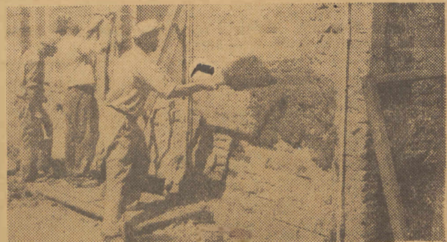
21 bm. zespół tynkarski pod kierownictwem Władysława Józko ustanowił nowy ogólnopolski rekord, pokrywając tynkiem w czasie 6 godzin 58,14 min. muru. Ustanowienie rekordu zostało umożliwione przez zastosowanie stalowych listew, pozwalających na znaczną oszczędność czasu pracy.
