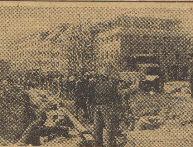
Powstaje nowa Warszawa. Prace przy budowie trasy W-Z dobiegają końca. Na zdjęciu robotnicy przy budowie nawierzchni na Pl. Zamkowym. W głębi odbudowane zabytkowe domy. Dwa pierwsze stoją na pokrywie tunelu.
