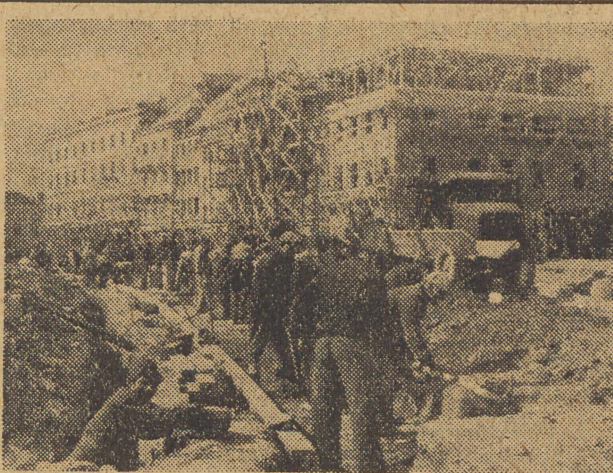
Powstaje nowa Warszawa. Prace przy budowie trasy W-Z dobiegają końca. Na zdjęciu robotnicy przy budowie nawierzchni na Pl. Zamkowym. W głębi odbudowane zabytkowe domy. Dwa pierwsze stoją na pokrytym tunelu.
