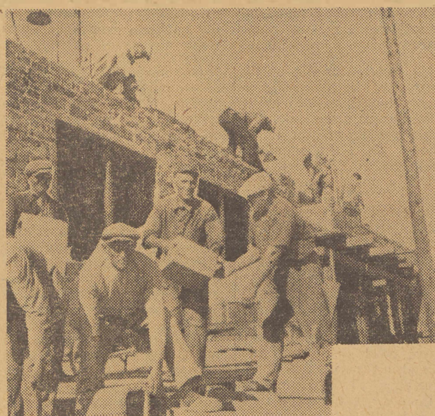
PPB. nr. 3 buduje nowe bloki mieszkalne dla świata pracy przy ul. Warszawskiej. Blok ma 73 m. długości i pomieści 45 mieszkań dwu i jednopokojowych. Na zdjęciu: murarze przy pracy, u dołu zespół brzdękiera Krajewskiego pracuje przy układaniu prefabrykatów na stropie wyrabiając 145% normy.
