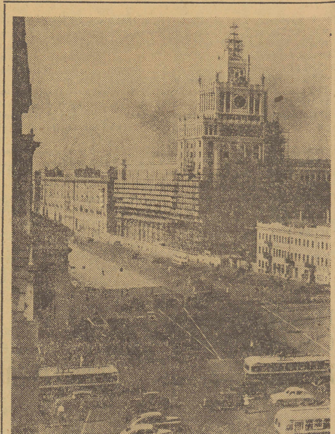
Rosną nowe budowle na placu Majakowskiego
