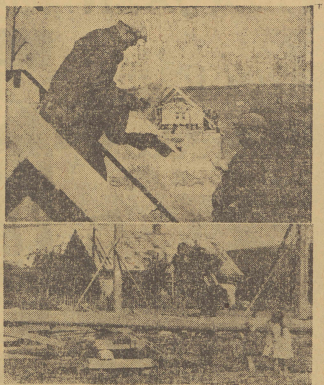
We wsi Krowniki budowane są nowe, wzorowe domy — murywane, zamiast drewnianych.
