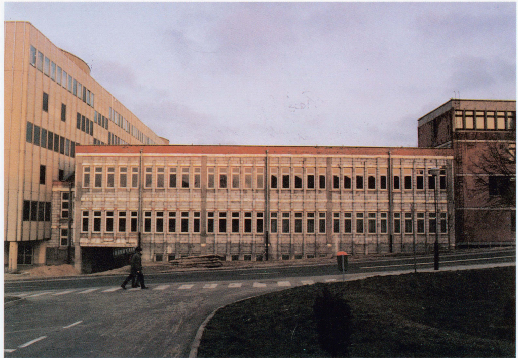
Łącznik biblieczny między gmachem głównym i międzywydziałowym budynkiem dydaktycznym. Siedziba Biblioteki Głównej
