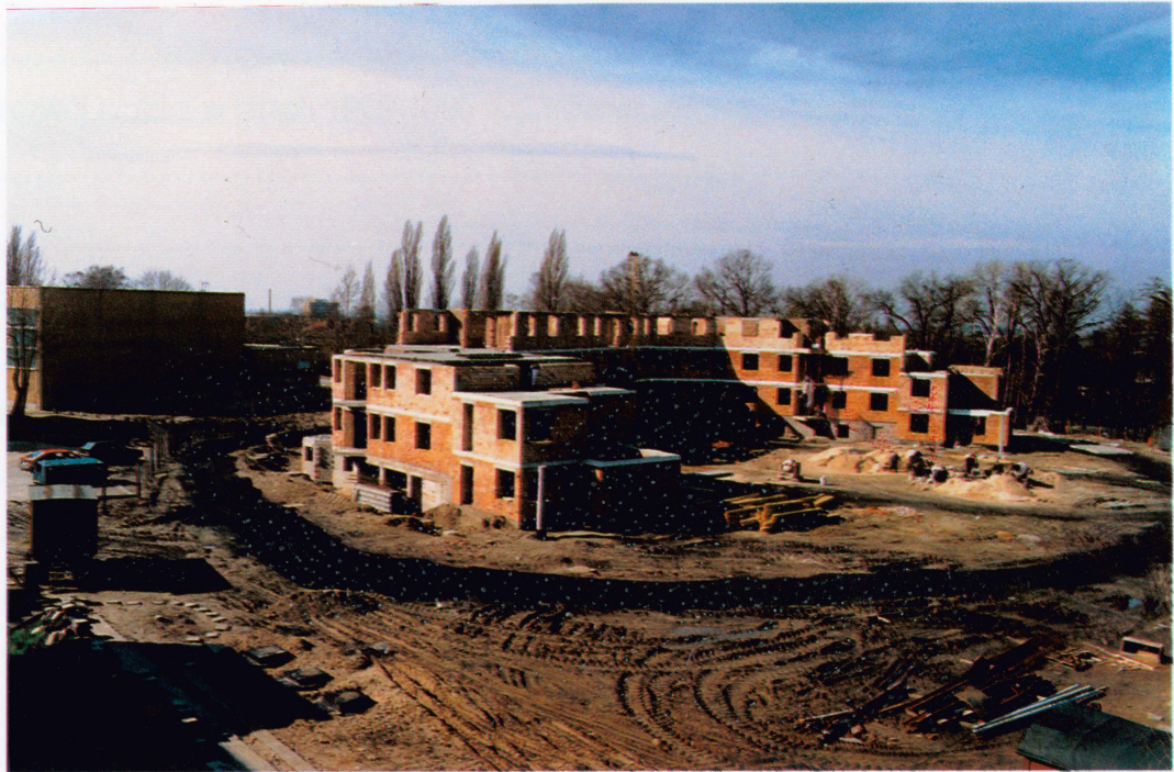
Budowa domu dla kadry
