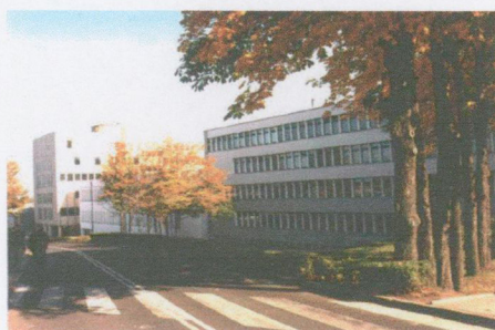
Fot. 4. Budynek Główny Politechniki Zielonogórskiej
