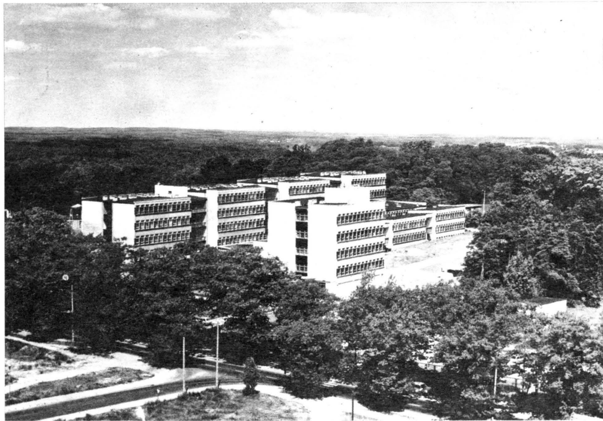
Budynki dydaktyczne - widok z góry
