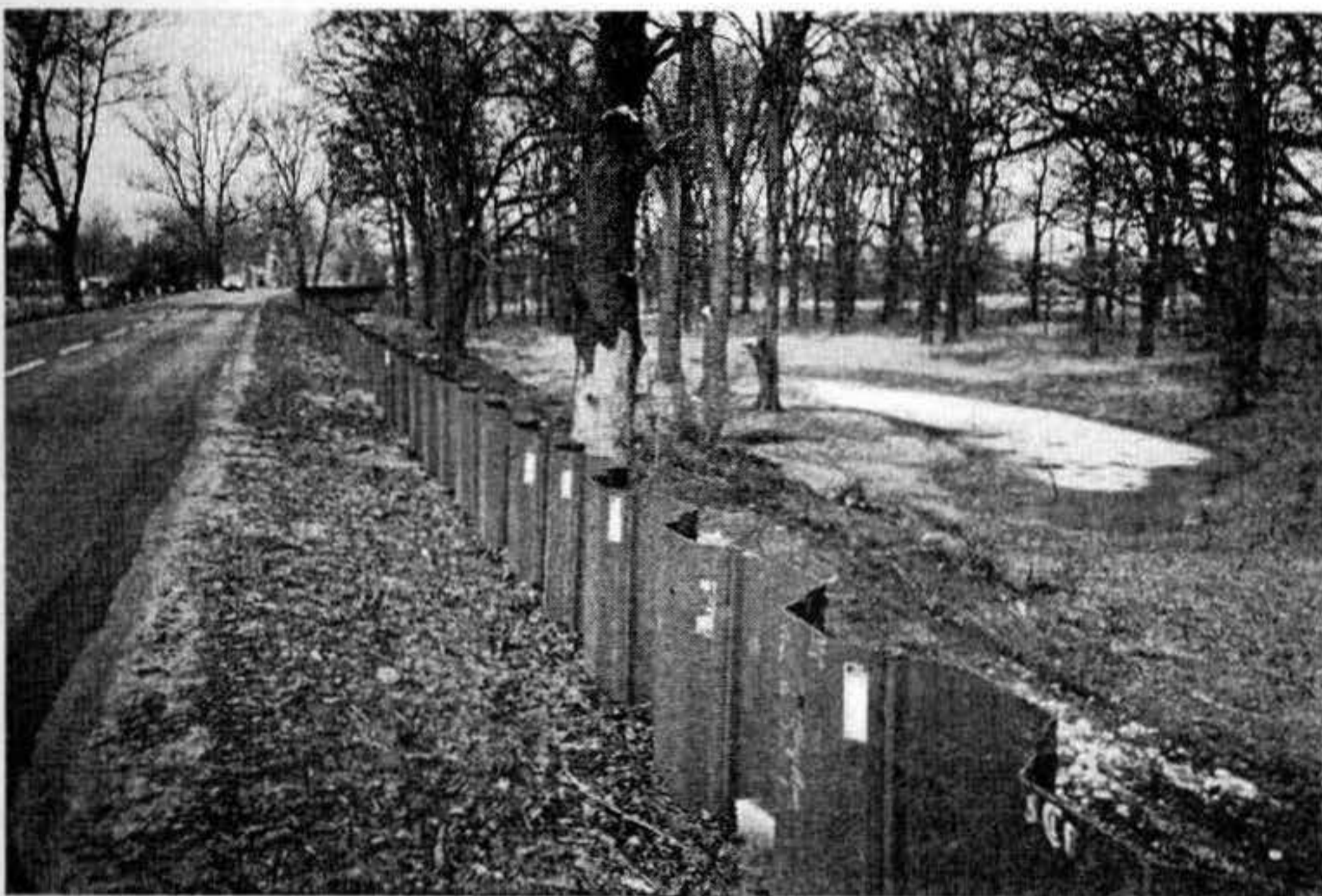
Foto 1. Sicherung der Böschung der Flussdeiche mit den Stahlspundwände – Fragment des Wegdammes in der Böschung der Flussdeiche, Regionalweg am Beispiel des Orts Nowa Sól
