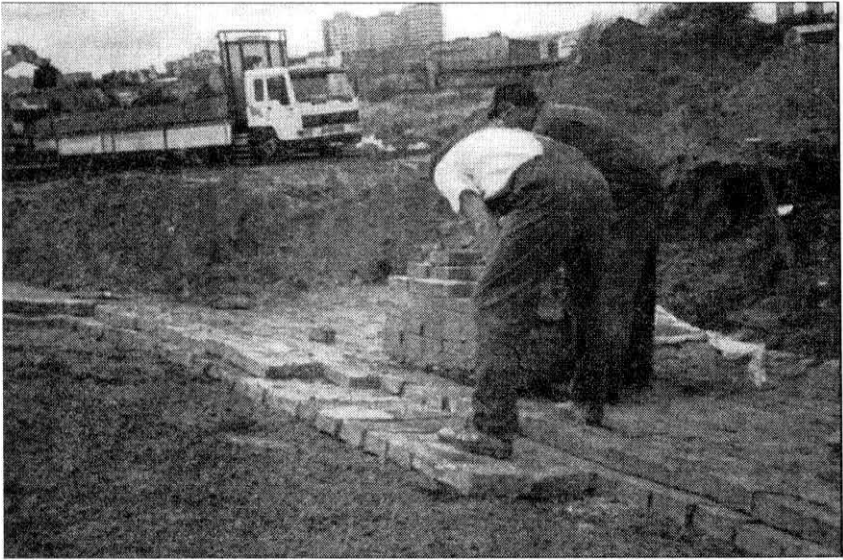
Foto 2. Dichtung der Böschung mit dem Lehmstein, Strecke Slubice - Górzycza
