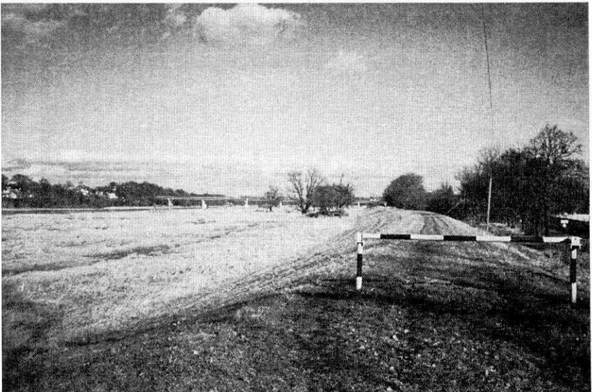
Foto 3. Dichtung der Rumpf und der Grund der Flussdeiche bei der Anwendung der PCV-Folie; Flussdeiche an der Strecke Leśna Góra – Cigacice - fünf Jahre nach der Modernisierung
