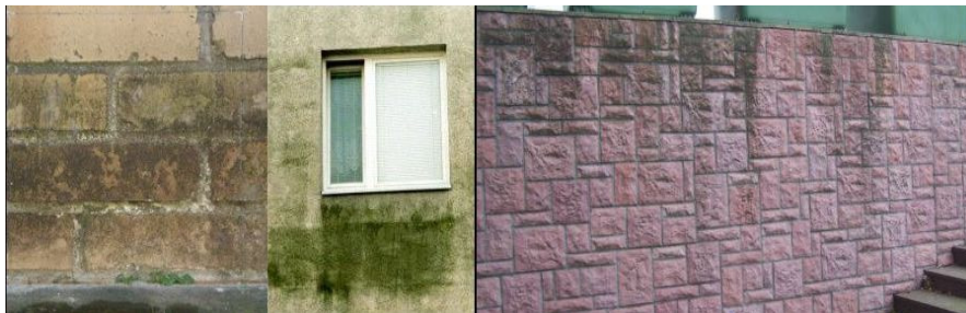
Fot. 1. Przykładowe elewacje z widoczną korozją biologiczną Phot.1. Examples of elevations with a visible biological corrosion
