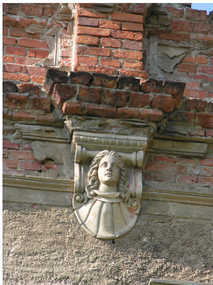
II. 11. Zamek w Siedlisku, zachowany wspornik w formie popiersia na elewacji ryzalitu skrzydła południowego, lata 60. XIX w. Stan z 2011 r. Fot. autorki
